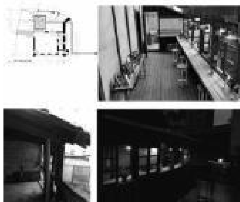
[그림 20] 2층 테라스 공사 전, 후
