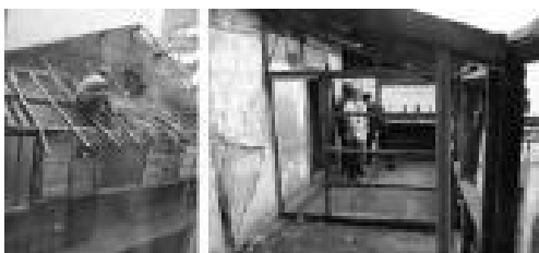
[그림 12] 시간이 많이 소용된 목조건물 철거
