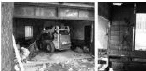
[그림 11] 1층 기존 창틀을 남겨두고 철거를 진행(좌)
