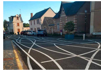
[그림 1] 도로 선형 표시 남용 사례
